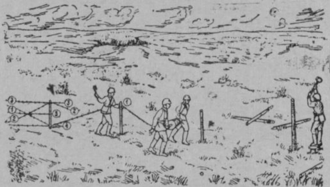
Рис. 123. Порядок оплетки одного ряда кольев проволочной сети (первого ряла).
