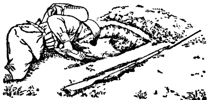
Рис. 79. Отрывка углубления для туловища и ног
