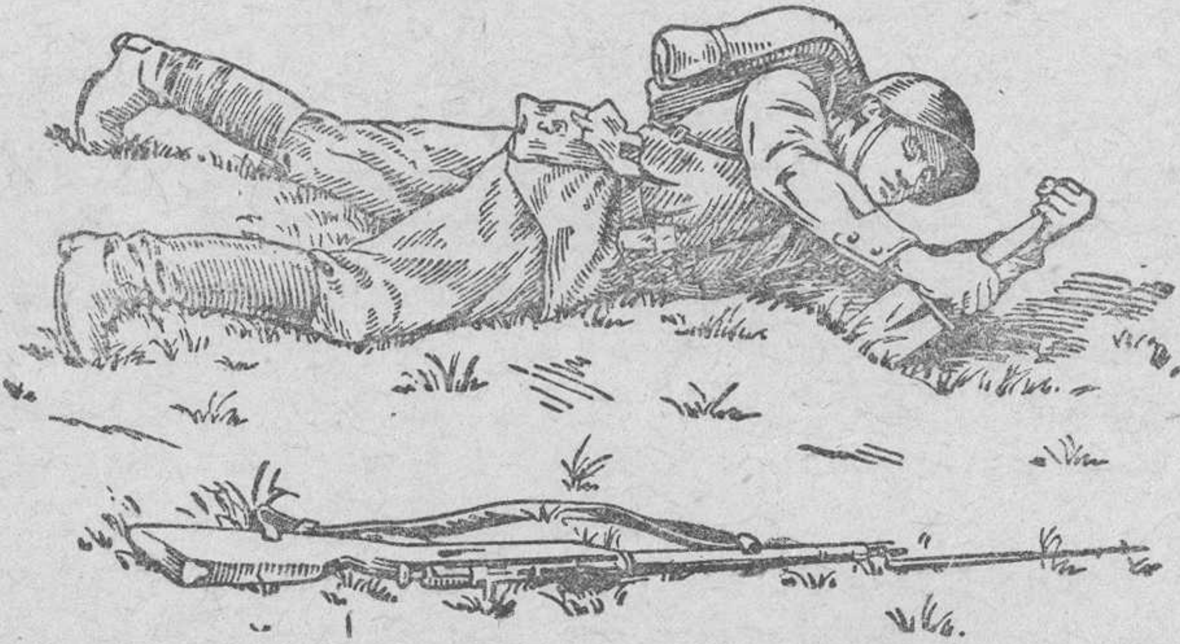
Рис. 18. Боец подрубает дерн в передней части ячейки
